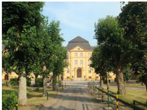
L'entrée côté rue de Reims (parking)
