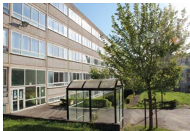
Campus de Nancy boulevard de Scarppone bâtiment G
